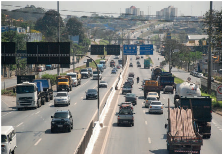
Ação inclui ampliação de viadutos, passarelas e acessos ao longo da via.
